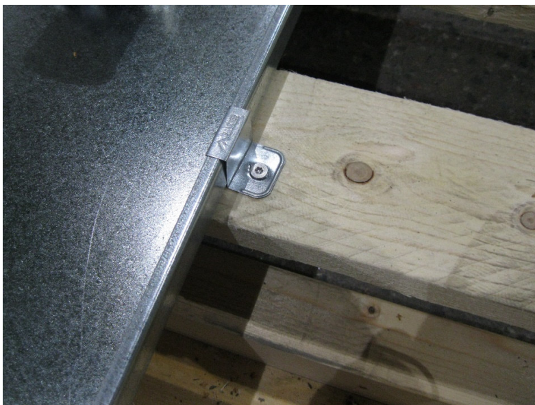
Kuva 3. Perinteinen yksittäinen kiinnike jossa ruuvi 3 x 26.
