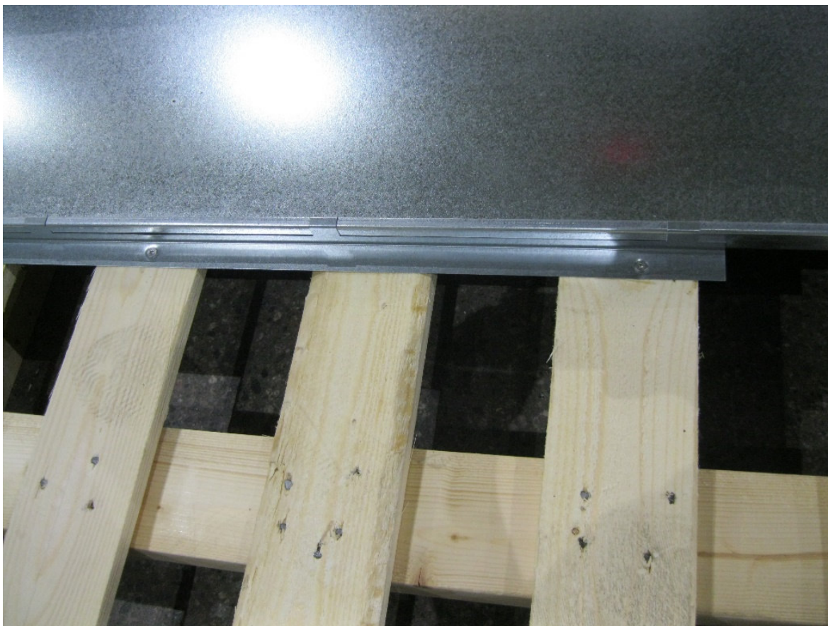
Kuva 2. Klemmarilista. Ruuvit 3 x 26 k 300 joka toisessa ruoteessa.
